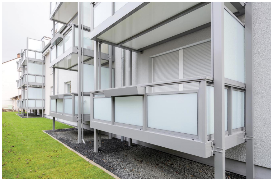
Auf der Gebäuderückseite wurden Vorstellbalkone errichtet.
